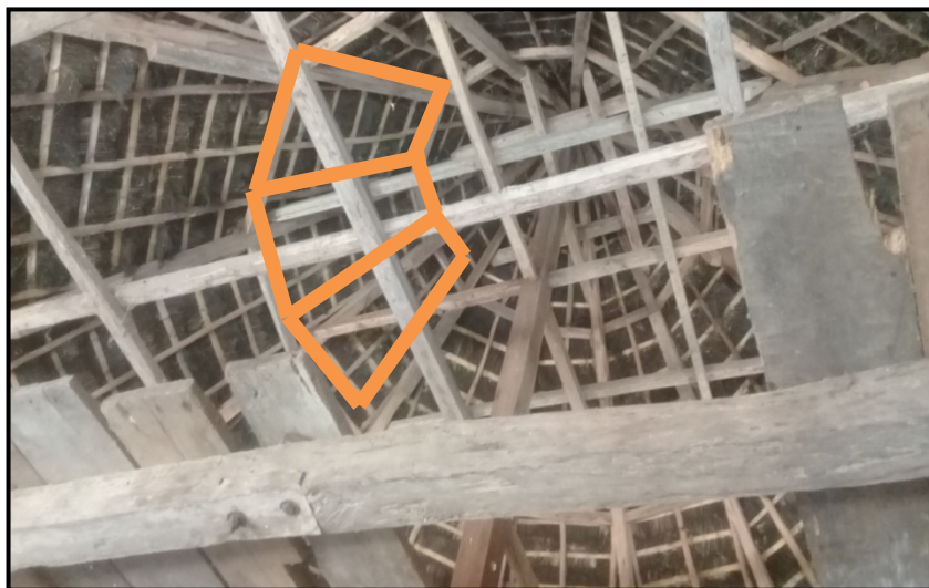
Gambar 6. Jaring atap mbaru niang yang menyerupai trapesium
