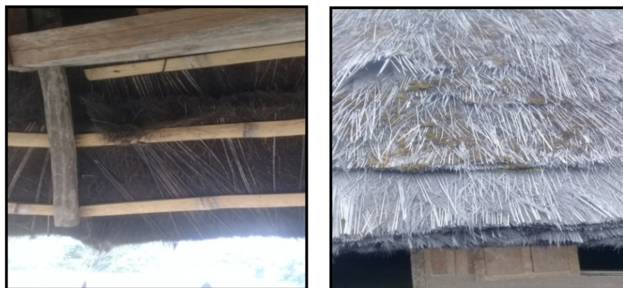
Gambar 7. Wunut pada atap mbaru niang
